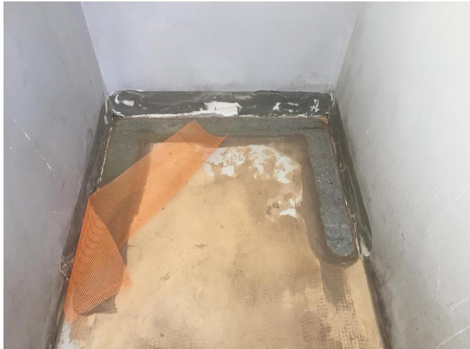
Anwendung eines Glasfaser-Netzes um etwaigen Rissen vorzubeugen
